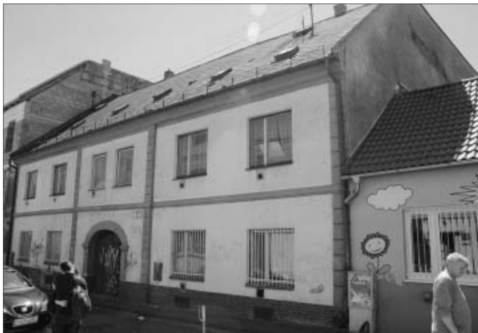
Budova na Jozefskej 6, kde prebiehajú stavebné úpravy
